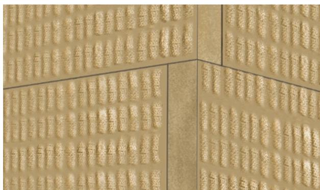
11. Монтаж плит на внешних углах осуществляется с перевязкой вертикальных стыков.
