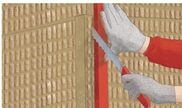
13. Излишки плит на торцах срезаются ножом после высыхания клея, затем поверхность среза зашлифовывается специальной теркой.
