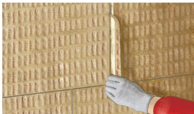
17. При неплотном прилегании плит друг к другу и наличии зазоров более 2 мм необходимо заполнить их клиновидными полосками, вырезанными из теплоизоляционной плиты.
