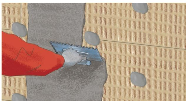
1. По истечении не менее суток после армирования углов можно производить армирование всей поверхности фасада. Работы лучше начинать сверху здания, двигаясь вниз и в сторону в виде «лесенки». Для достижения хорошей адгезии армирующего состава с поверхностью плит требуется нанесение предварительного слоя РОКмортар путем втирания в поверхность утеплителя гладкой стороной шпателя.
