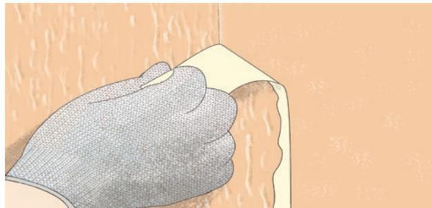
7. Работы на одной поверхности следует выполнять непрерывно, придерживаясь правила нанесения «мокрое по мокрому». Работы могут быть приостановлены только при установке клейкой малярной ленты на границе отделки перед нанесением крайней полосы штукатурного слоя. После нанесения крайней полосы штукатурного слоя до его высыхания необходимо удалить малярную ленту.
