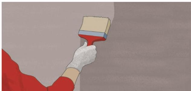
1. Окончательная отделка фасада возможна по истечении не менее 3 суток после нанесения базового штукатурного слоя. Для достижения хорошей адгезии поверхность армирующего слоя грунтуется грунтовкой при помощи кисти или валика.
