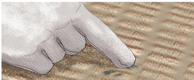
1. Необходимо проверить поверхность теплоизоляционных плит на предмет наличия инородных включений и удалить при наличии.
