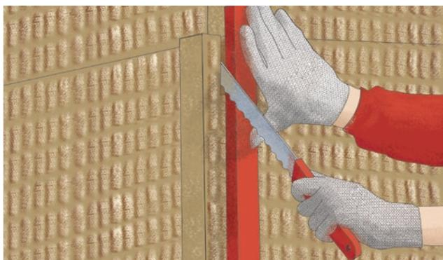
13. Излишки плит на торцах срезаются ножом после высыхания клея, после чего поверхность среза зашлифовывается специальной теркой.
