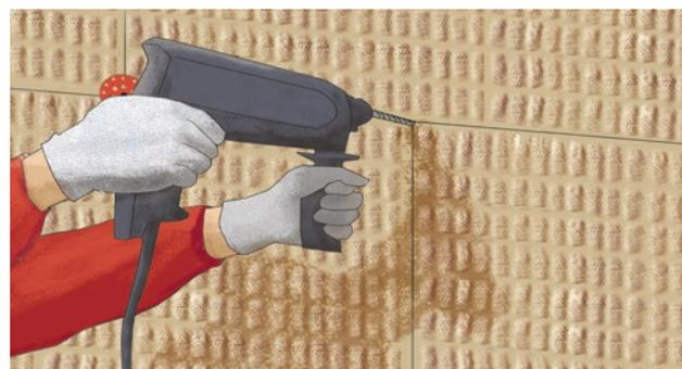
2. Для просверливания отверстий используется дрель со сверлом диаметром 8 мм необходимой длины, учитывающей толщину плиты утеплителя и глубину анкеровки. Глубина засверливания должна быть больше глубины анкеровки на 10-15 мм.
