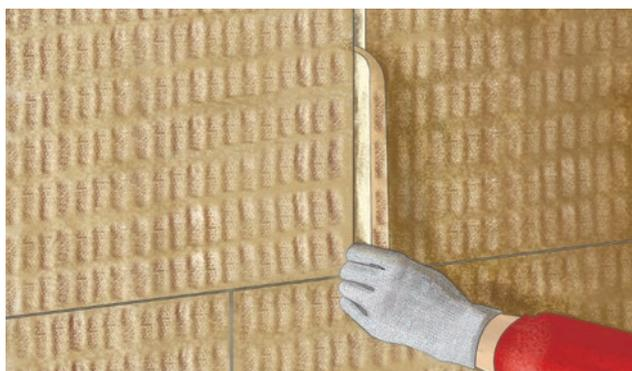
17. При неплотном прилегании плит друг к другу и наличии зазоров более 2 мм необходимо заполнить их клиновидными полосками, вырезанными из теплоизоляционной плиты.
