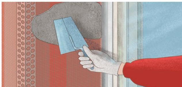
5. Далее в этот профиль заводится армирующий слой базово-клеявого состава с сеткой от армирующего уголка. Если сетки от армирующего уголка и профиля примыкания недостаточно для перехлеста, необходимо вырезать полосу сетки для обеспечения полного армирования откосов и их угловых частей.
